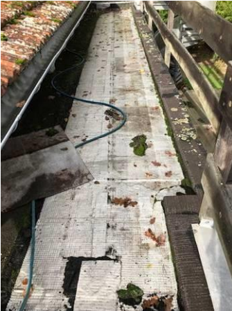
Photo n° PhA004 Localisation : Couverture Ouvrage : Toitures Partie d'ouvrage : Bardeaux bitumineux Description : Bardeaux bitumineux
